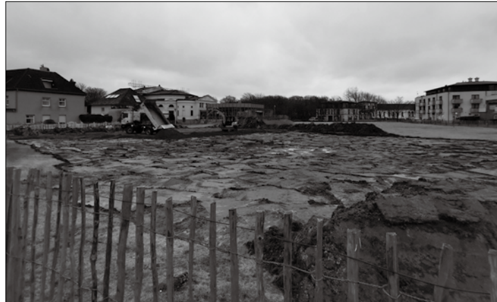
Mit Mutterboden und Sand wird die Bodensenke gefüllt. Foto: Sykora
