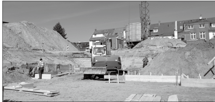
Derzeit wird die Verschalung in der Baugrube angebracht, damit die Bodenplatte gegossen werden kann. Foto: Sykora
