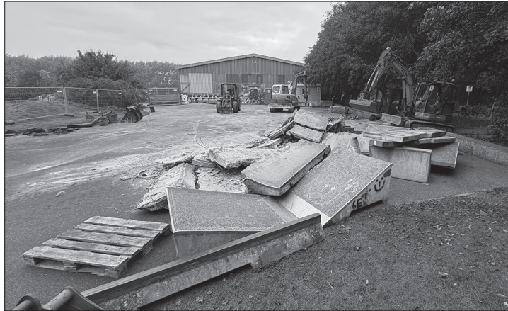
Die alte Betonanlage ist seit Anfang der Woche zerlegt und abtransportiert. Foto: Stadt Norderney
