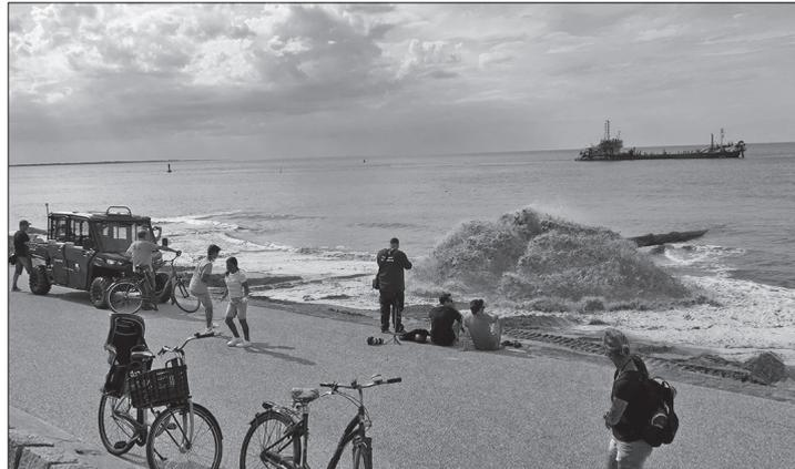
*O'zapft is: Direkt vor der Milchbar sprudelt seit gestern Nachmittag das Sand-Wasser-Gemisch aus dem Spülrohr. Im Hintergrund: der Saugbagger „Thor R“.*
