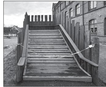
Der Spielturm hat eine Rampe erhalten. Es fehlen noch Taue.
