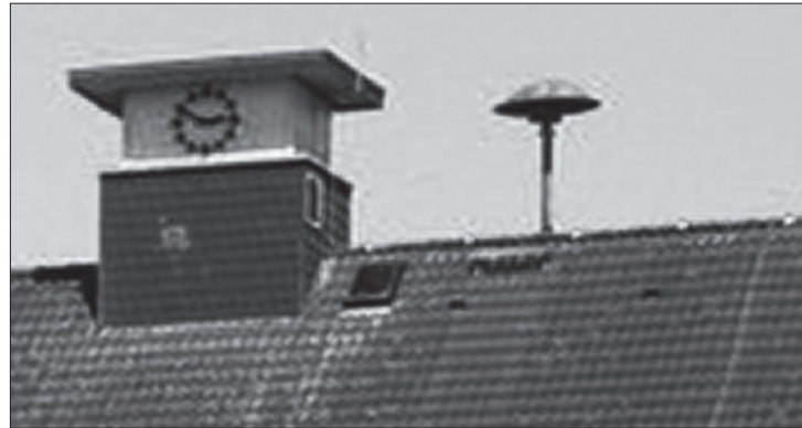
Die Sirene auf dem Haus der Begegnung ist schon lange nicht mehr in Betrieb. Der Landkreis arbeitet jedoch an einem neuen Sirenenetz. Foto: Archiv/Pape
