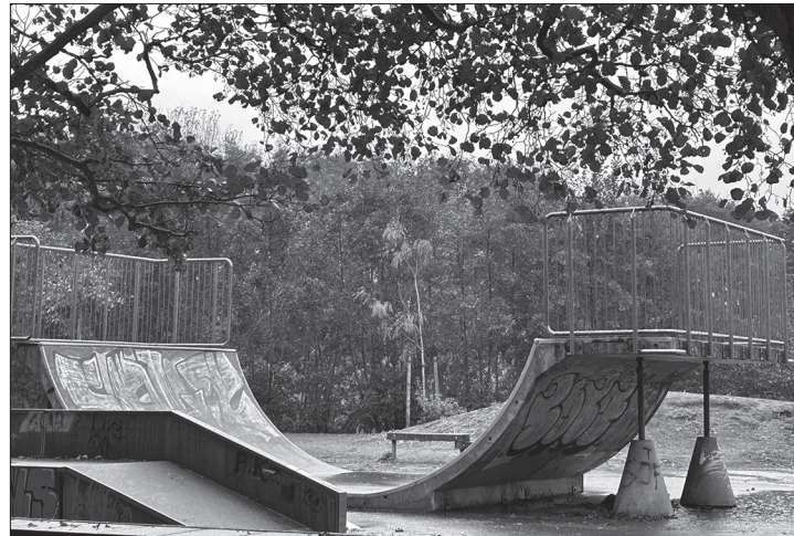
Der Förderbescheid für eine neue Skateanlage über den Wattenmeer-Achter gilt als sicher. Die Rückbauarbeiten könnten bereits im Herbst starten. Foto: Pape
