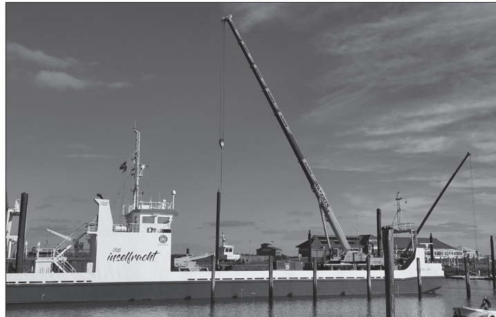
Im Norderneyer Jachthafen werden derzeit Stahlpfähle eingesetzt, die künftig die Betonstege sichern. Foto: Linke
