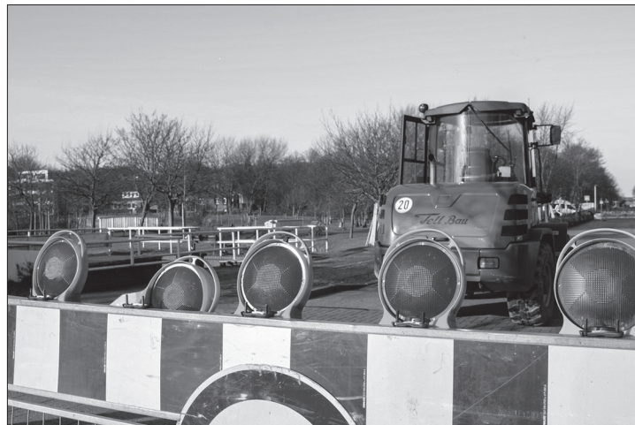
Die Mühlenstraße ist in den kommenden zwei Monaten aufgrund von Arbeiten an einem großen Regenwasserkanal voll gesperrt. Foto: Pape
