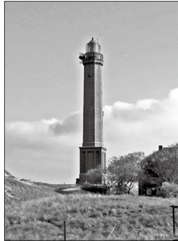
Der Leuchtturm ist ab Montag wegen Sanierungsarbeiten geschlossen. Foto: Sykora
