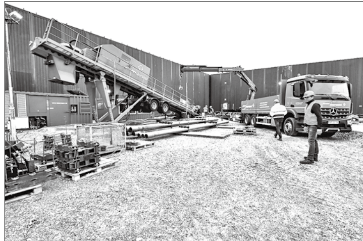
Ab 15. Juli wird Tennet wieder die Baustelle für die Horizontalbohrungen am Leuchtturm einrichten. Foto: Pape/Archiv
