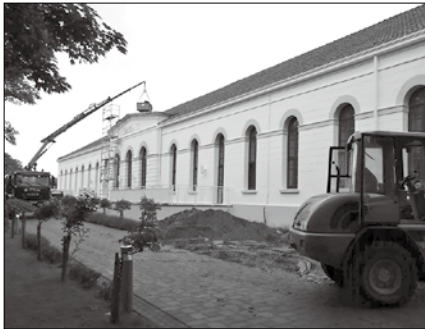
Gestern wurde das Gerüst am Conversationshaus abgebaut. Foto: Linke
