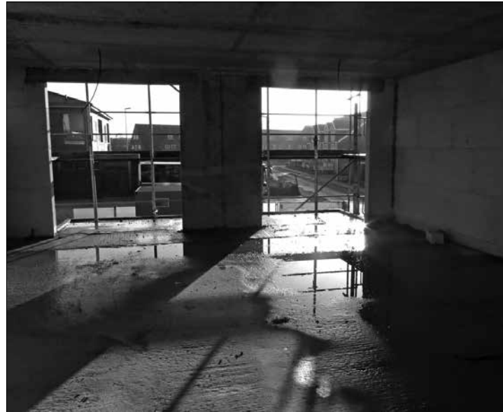
Der Blick in eine der Wohnungen. Noch fehlen die Zwischenwände, die mit Rigips eingesetzt werden. Foto: Sabine Sykora
