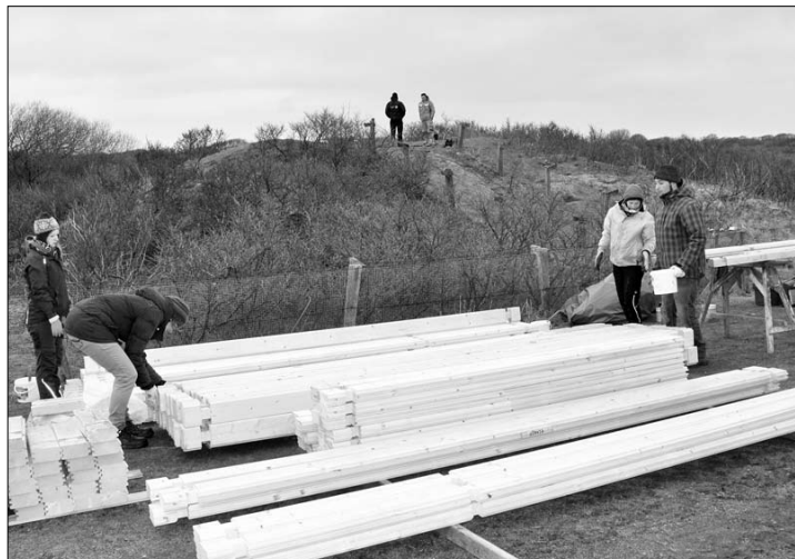
Erstmal das Holz imprägnieren hier (v.l.n.r.) Jana Kessens und Jule Isbrand vom NABU Woldenhof aus Wiegboldsbur und die Bundesfreiwilligen Meike Schulz und Clemens Pätze vom NLWKN. Im Hintergrund auf der Anhöhe steht das Fundament der Beobachtungshütte. Foto: Rass
