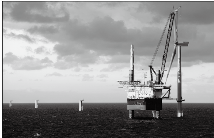
Die erste Anlage des Offshore-Windparks „Borkum-Riffgrund 1“ ist jetzt aufgebaut. Foto: Dong-Energy
