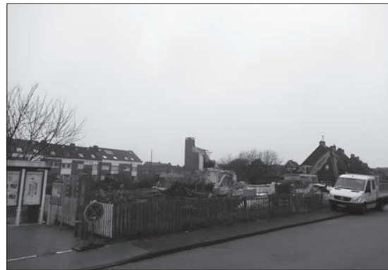
Das alte Pastorat auf dem Kirchengrundstück ist abgerissen.
