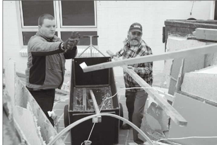
Die letzten Reste ab auf den Container: Peter „Ziege“ Meyenburg (re.) und Sven Rass entsorgen ehemaliges Inventar der Nordstrandhalle.
