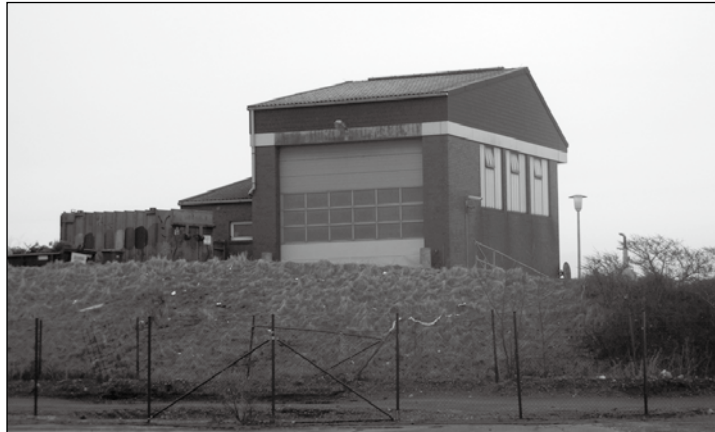
Die Müll-Umschlagstation an der Deichstraße ist in die Jahre gekommen und soll ab Herbst neu gebaut werden.
