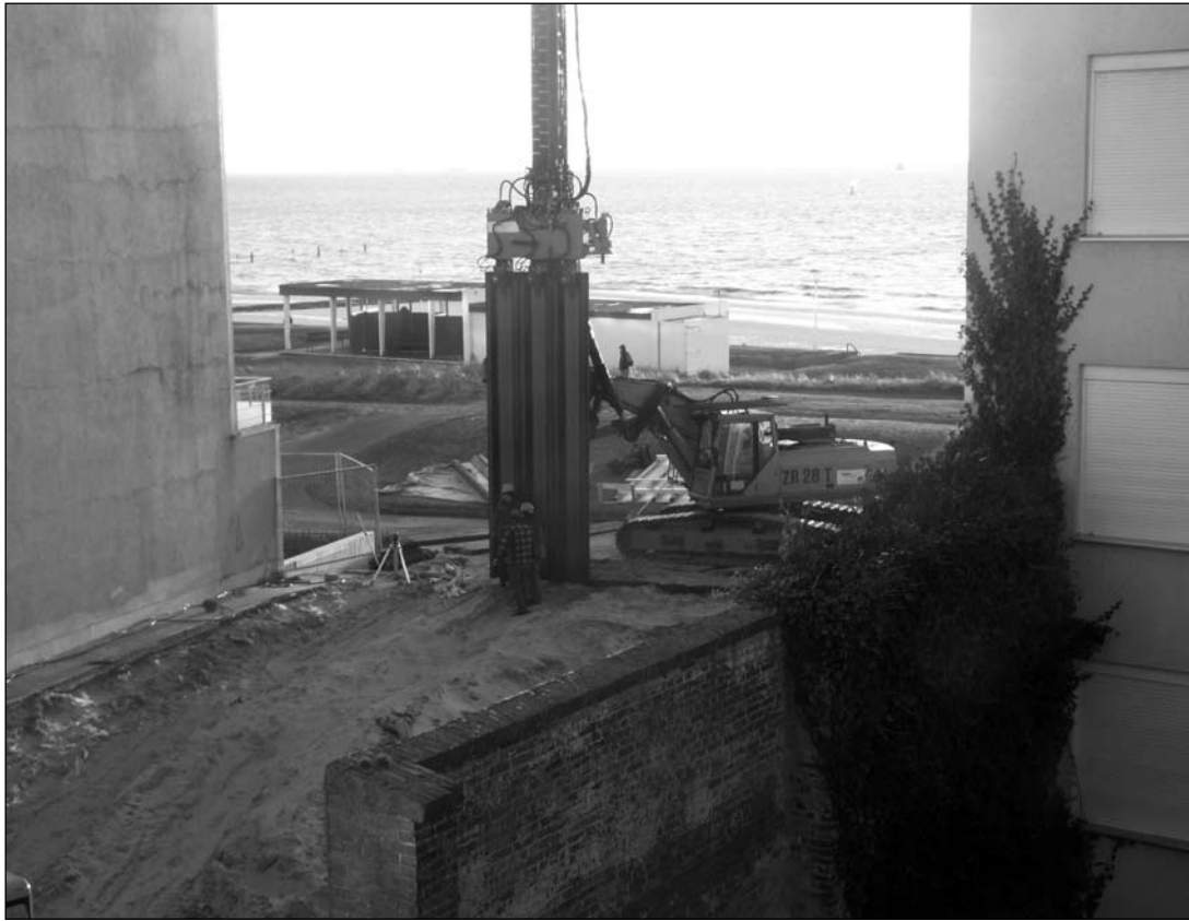
Blick auf die Baulücke von Osten: In der vergangenen Woche wurden die Spundwände gesetzt.
