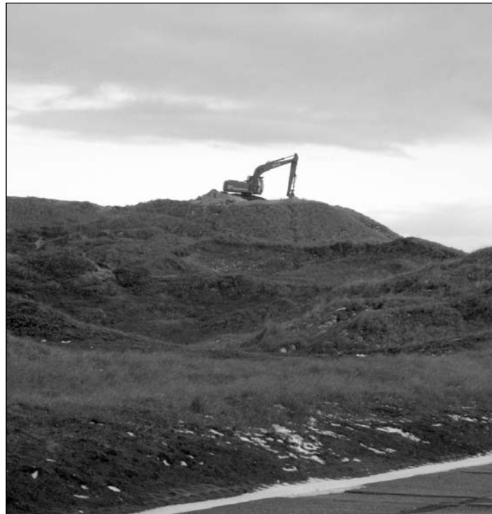
Bagger auf der Düne: Gestern Mittag am Karl-Rieger-Weg. Foto: Kähler
