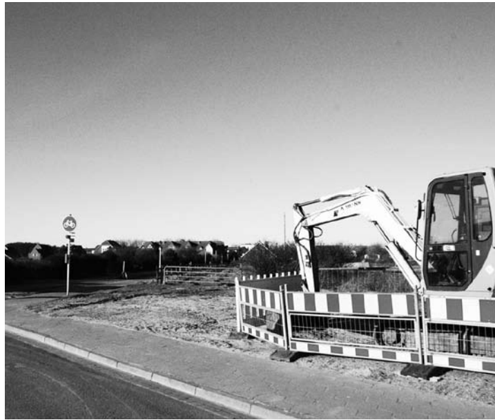
Am Habenpatt steht der Bagger still.
